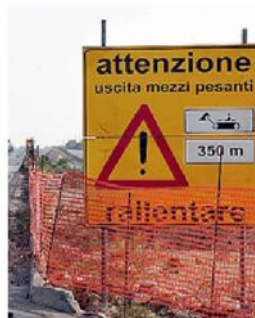
CANTIERI Nuove opere
